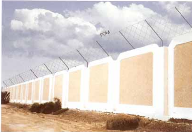
Fig. 1 FOM over Wall
